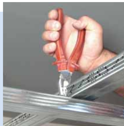
Pro optimální výsledek montáže úhlové kotvy je vhodné použít kleště
