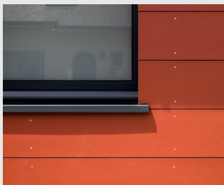
Horizontální pokládká s otevřenými spárami
