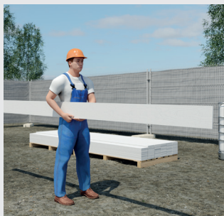
Fasádní desky HardiePlank® noste vždy na výšku
