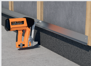
Upevnění soklového ventilačního profilu.
