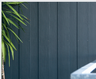
Upevnění je možné hřebíky nebo šrouby s nabarvenou hlavičkou
