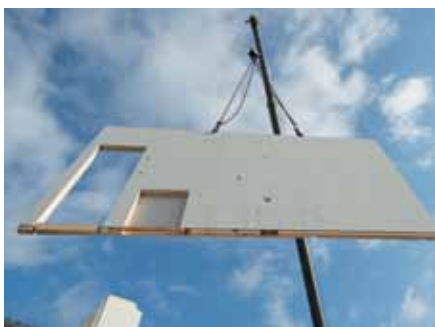
Staveništní doprava jeřábem
