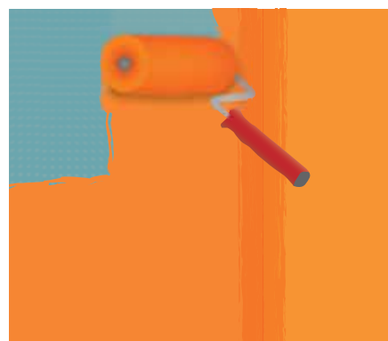
Tekutá fólie fermacell se nanáší celoplošně válečkem ve dvou vrstvách (celková tloušťka \geq 0,5 mm), doba schnutí: min. 2-3 hodiny
