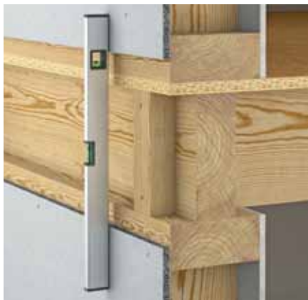
Obr. 1: vyrovnaní stěny
