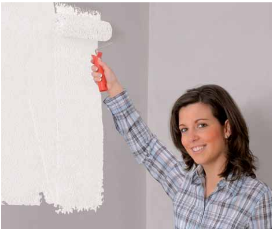
Válečkovanou omítku fermacell je možno přetřít disperzní, latexovou, akrylátovou nebo silikonovou barvou.
