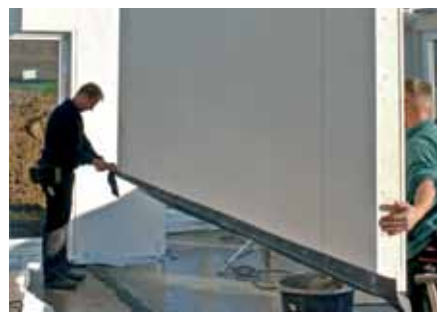
Osazení stěnového panelu do maltového lože
