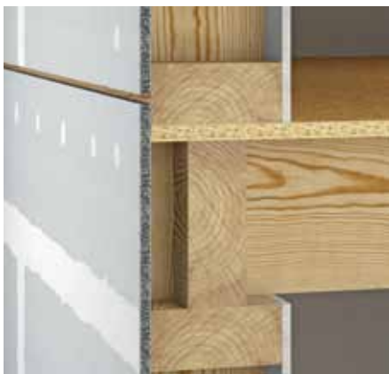
Obr. 3: Oblast pruhu desky opatřená spárovací technikou HD
