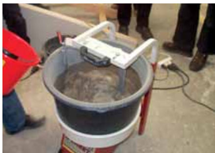
Míchání výplňové malty fermacell
