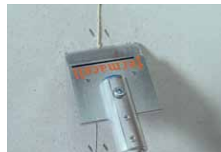
Odstranění přetoků lepidla pomocí škrabky fermacell
