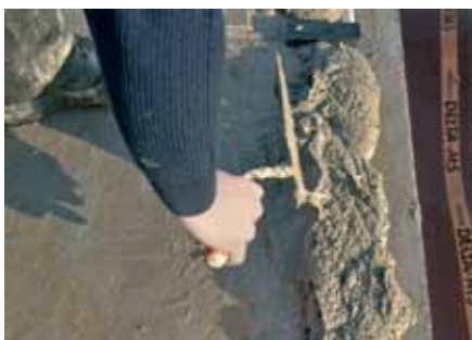
Nanášení maltového lože
