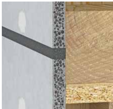
Obr. 4: Uzavření spáry předkomprimovaným těsnícím pásem (detail)
