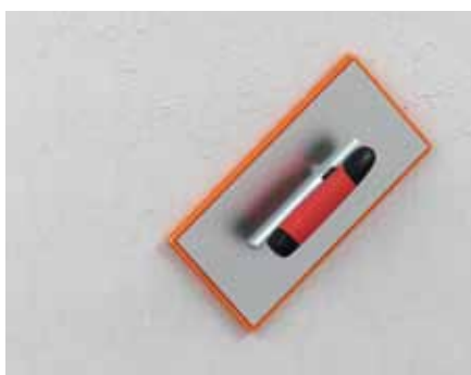
Úprava povrchu omítky pomocí pěnového hladítka
