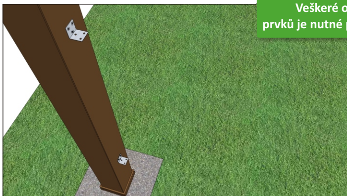
Připevnění klipů ke sloupkům
